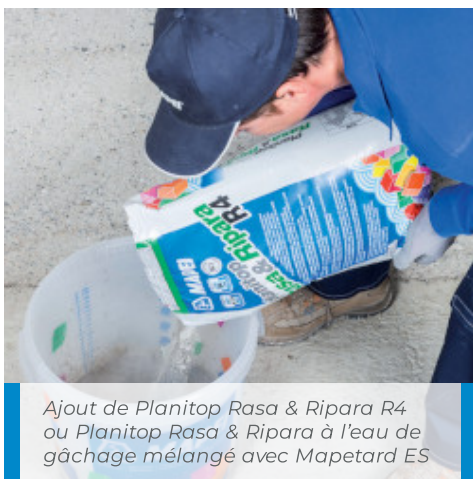
Mélange de Planitop Rasa & Ripara R4 ou Planitop Rasa & Ripara
