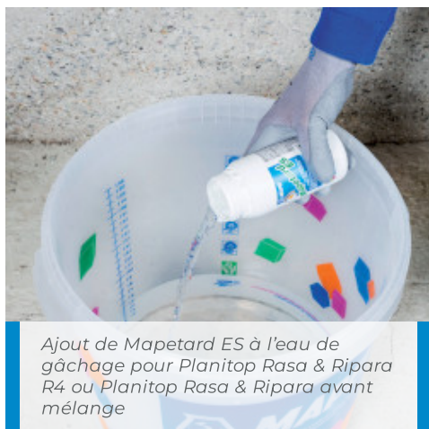
Ajout de Planitop Rasa & Ripara R4 ou Planitop Rasa & Ripara à l'eau de gâchage mélangé avec Mapetard ES
