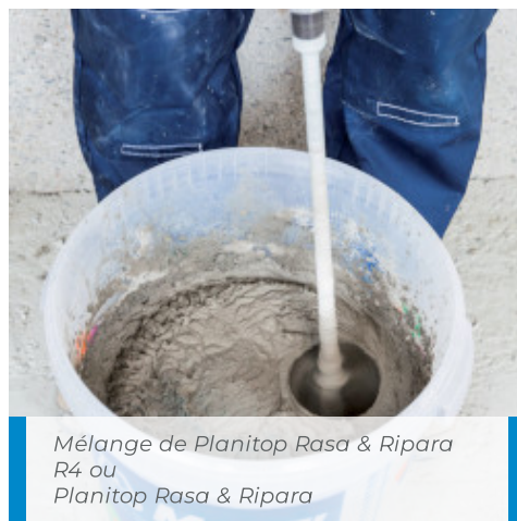
Ajout de Planitop Rasa & Ripara R4 ou Planitop Rasa & Ripara à l'eau de gâchage mélangé avec Mapetard ES
